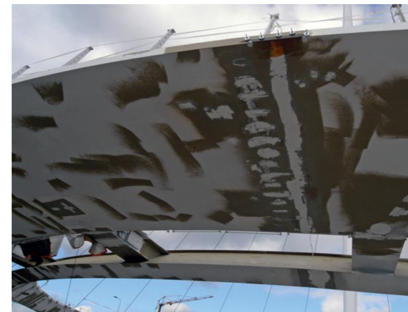
Op een soortgelijke plek in de Hovenring zijn de delen inmiddels voorzien van een eerste witte coating. Op de donkergrijze plekken zit primer, het wit op de grijze vlakken is plamuur, onder andere ter hoogte van de las die de twee segmenten aan elkaar koppelt. Op de buitenste rand van het brugdek is met magneetjes een mal aangebracht om ervoor te zorgen dat de ronding hier conform die van de rest van het brugdek wordt. De ruimte tussen mal en brugrand is opgevuld met een plamuur op epoxy-basis.
