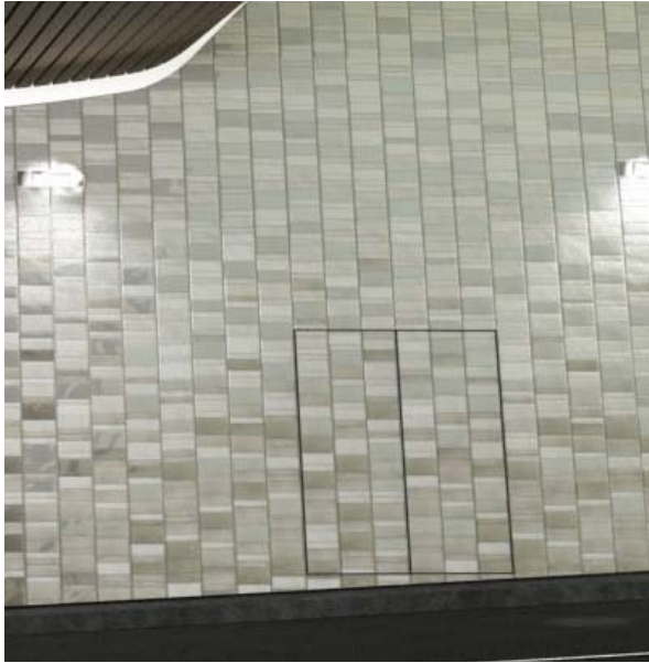
BETEGELDE DEUREN: VAN ONTWERP NAAR UITVOERING
