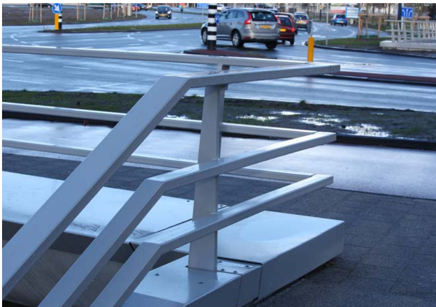
HOEKAANSLUITING NIET-VOERTUIGKEREND HEKWERK BIJ DR. LELYLAAN
