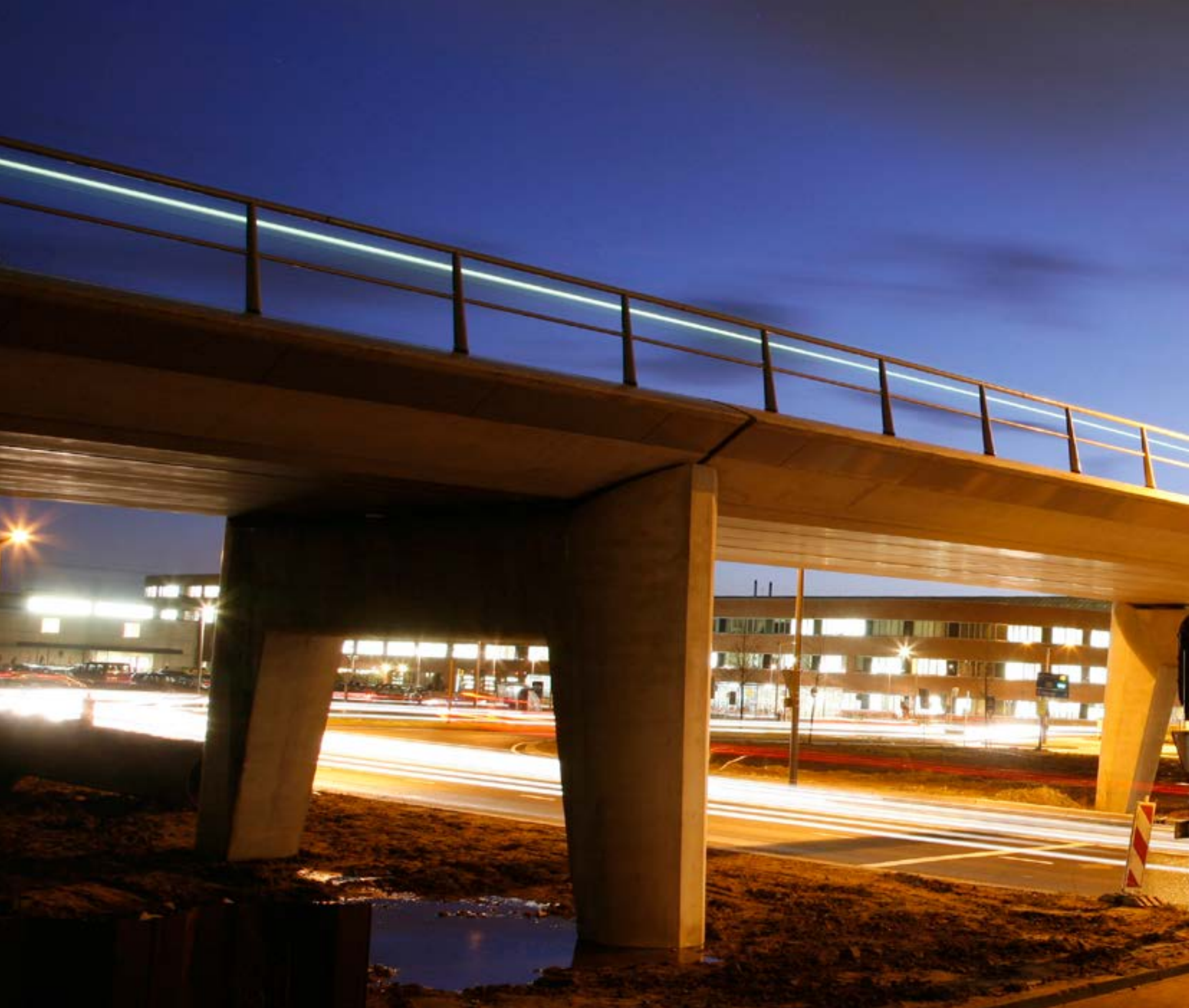
busbaanbrug Almere | 2011 l = 200 m | b = 10,4 m | € 4.000.000
