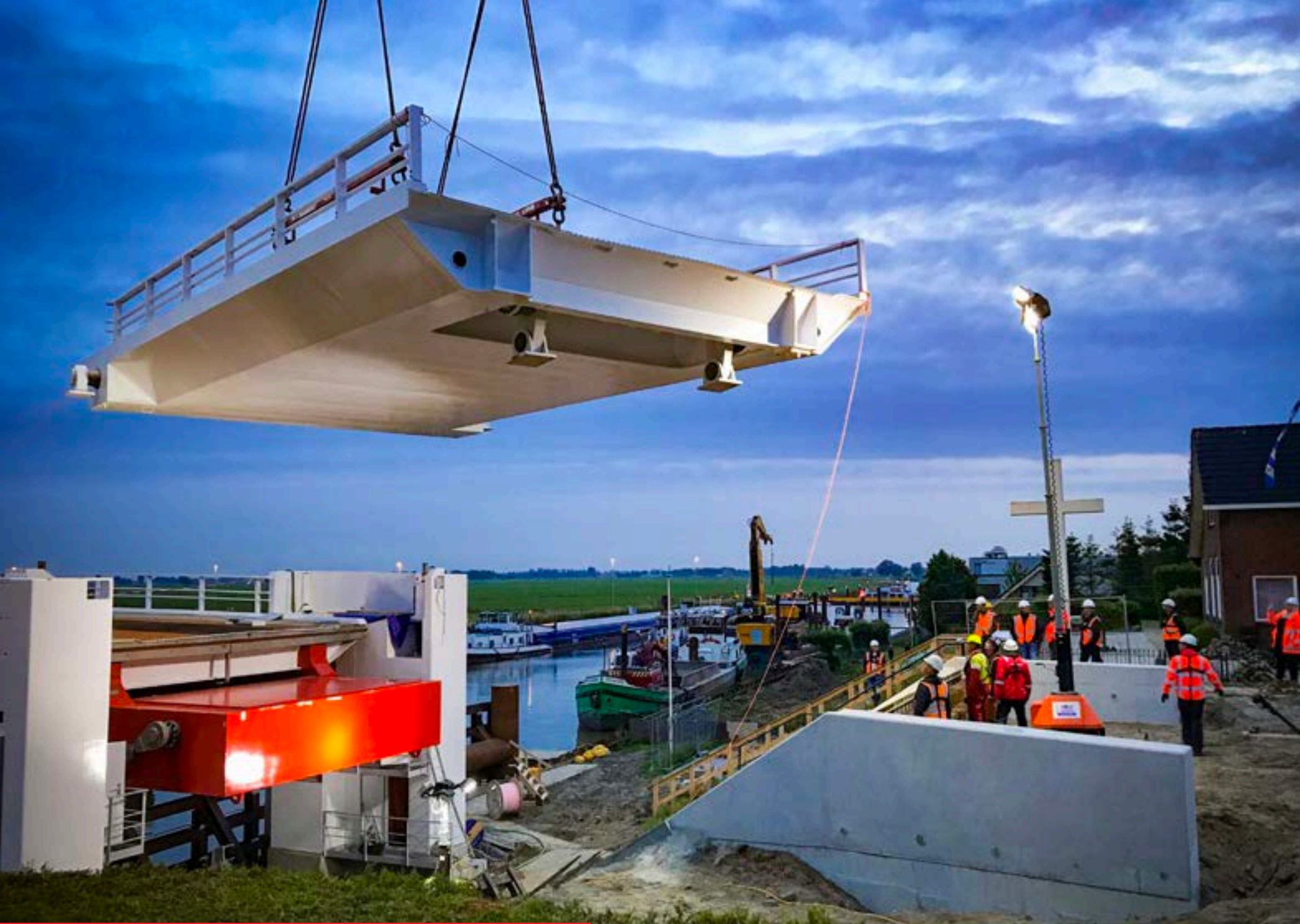
Het inhijzen van de noordelijke aanbrug gebeurt vakkundig en op de millimeter nauwkeurig.
