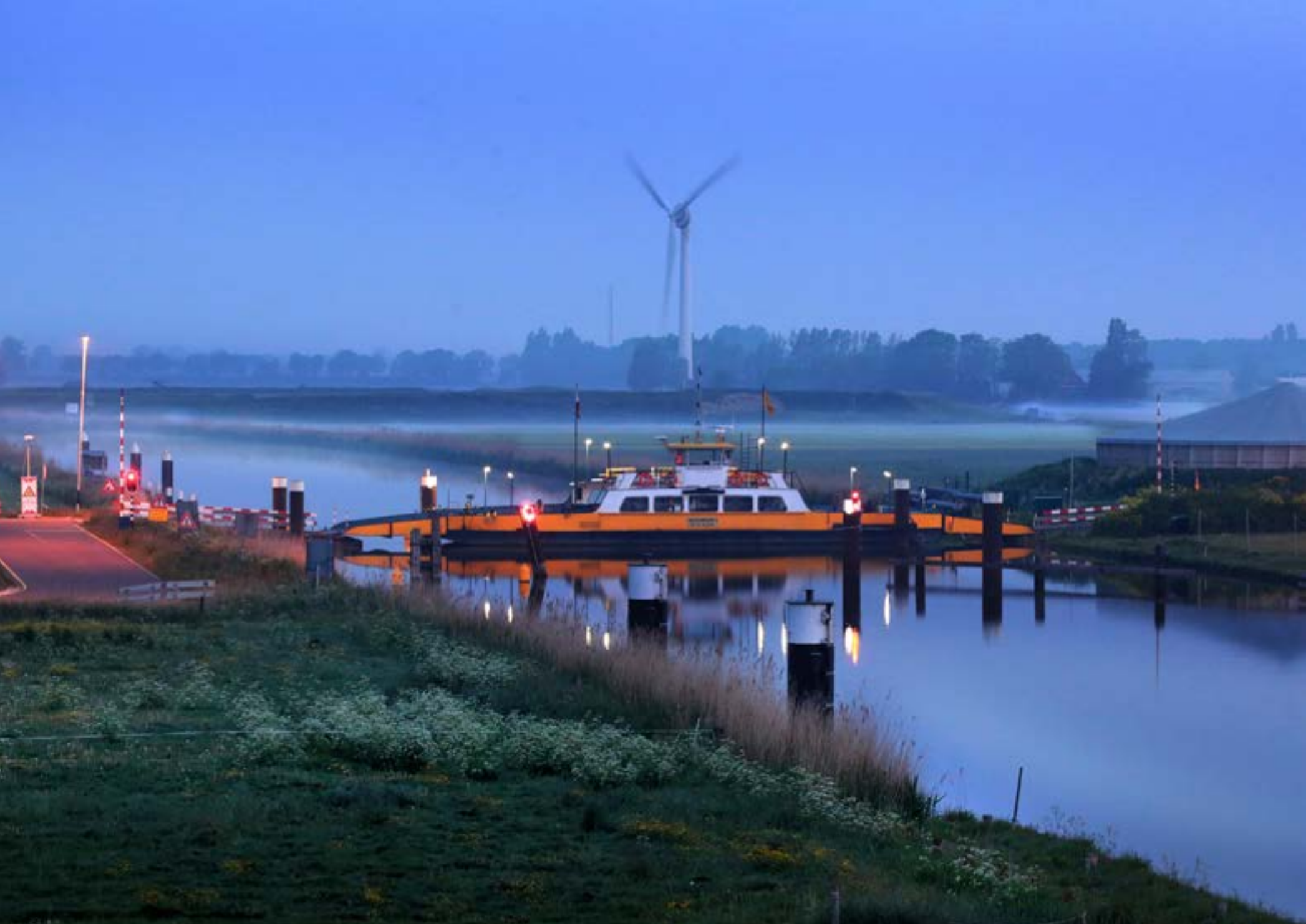
De tijdelijke vlotbrug in de schemering. Als er vaarverkeer aankwam werden de kleppen opgehaald en draaide de pont negentig graden naar één oever.
