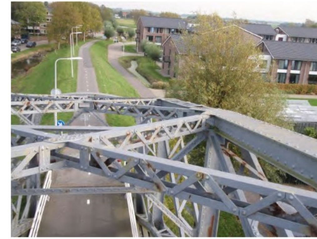
Foto 2.18: verbanden en spanten tussen de bogen
