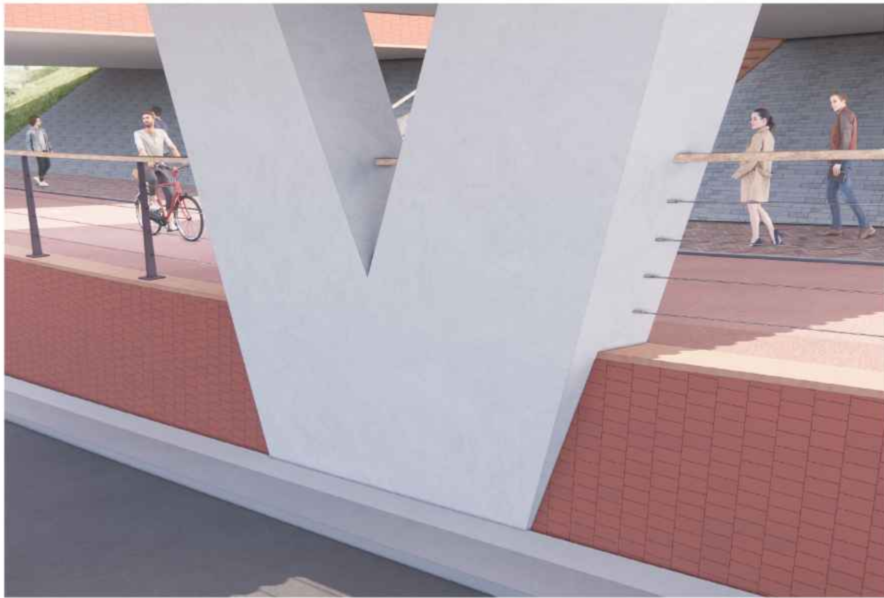
Kolom gezien vanaf rijbaan: kolomvoet steekt 5 cm uit ten opzichte van de wand, spankabels en handregel verzorgd bevestigd.
