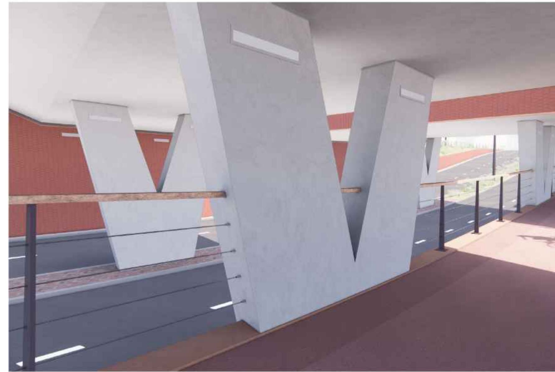
Kolom gezien vanaf het fietspad. Een uitneembare / te openen stalen rand neemt de opleggingen uit het zicht.
