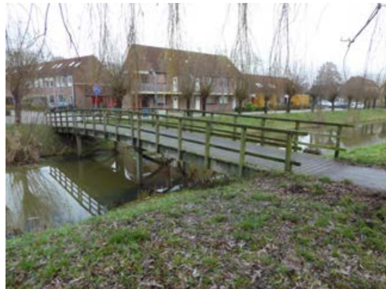
0017 - HOUTEN VOETGANGERS-, FIETSBRUG
