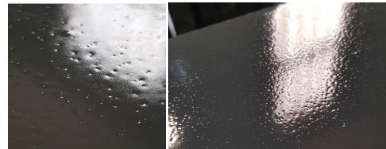
Kraters en pinholes – appelsienhuid allemaal aanwezig en niet hersteld (nu onder anti-graffiti laag)
