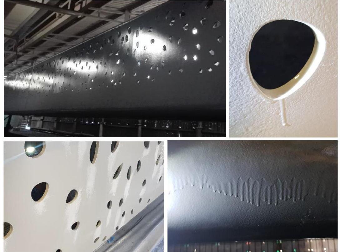
Afgewerkte brug met lopers PSX 700 clearcoat (ook op zijkanten van de brug)
