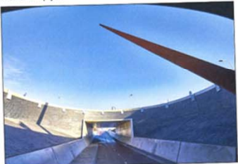
Fig. 2. De markante cortenstalen naald is 17 meter hoog. Het hart van de rotonde wordt aangelicht vanuit de punt van de naald. Dit maakt lichtmasten overbodig. ©Arjan Gotink Fotografie
