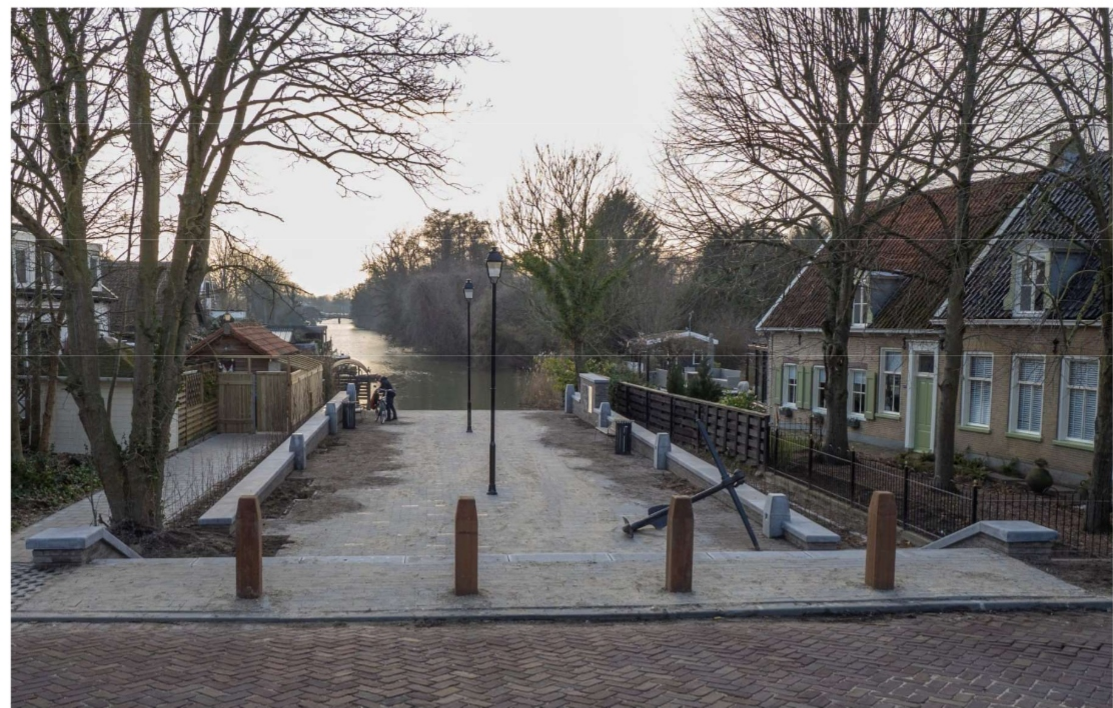
irnichtung plein: doorlopen van water met riet
